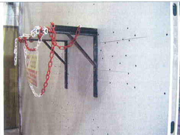
Colocación de la estantería para ensayos
