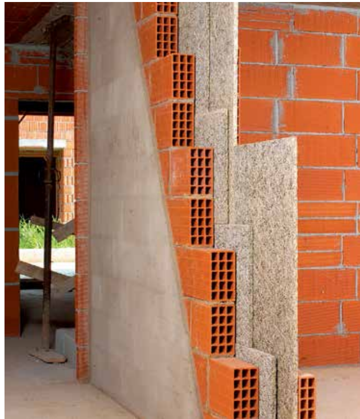
Los tabiques se levantan sobre una tira de Celenit N de 25 mm.
