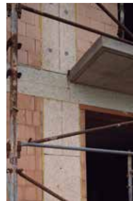
Eliminación de puentes térmicos.
