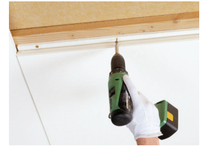
Master F se instala con fijación mecánica
