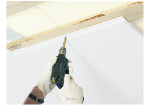
Fijación mecánica de las placas Focus F
