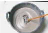
• Amasar weberfloor 4630 industry lit con 4-4,2 litros de agua limpia por saco de 25 kg mediante batidor eléctrico o máquina de bombear hasta obtener una mezcla homogénea y sin grumos. Las propiedades de fluidez del producto deberán ser comprobadas mediante un ensayo de fluidez (180-200 mm de diámetro con el cono estándar Weber) antes y durante el bombeo, empleando un anillo medidor de flujo y una placa.
